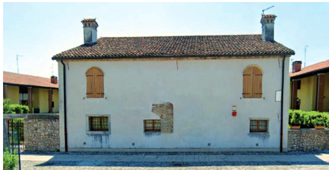
Casello di guardia - Sede della mostra, Via De Pellegrini
